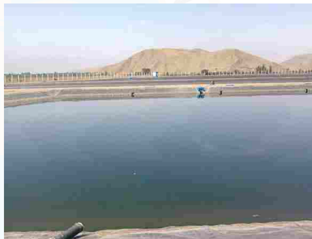
Figura 2. Entrada a la laguna de aireación y conexión con la siguiente laguna (PTAR de Quilmaná).
